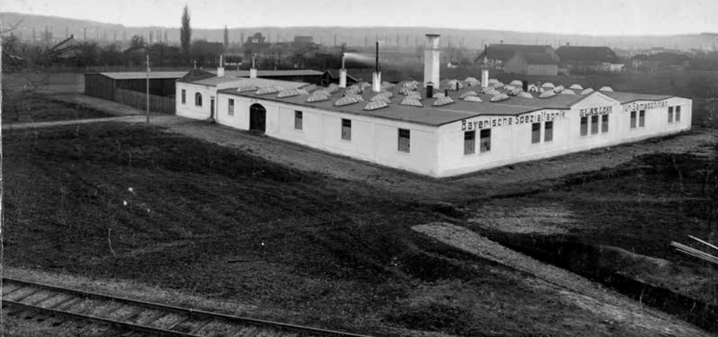
Die neuerbaute erste Fabrik der Firma Glas & Lohr, Bayerische Spezialfabrik für Sämaschinen, 1908
